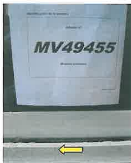
Zona de filtración de água
