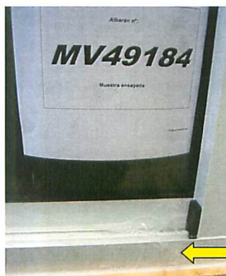
Zona de filtración de água
