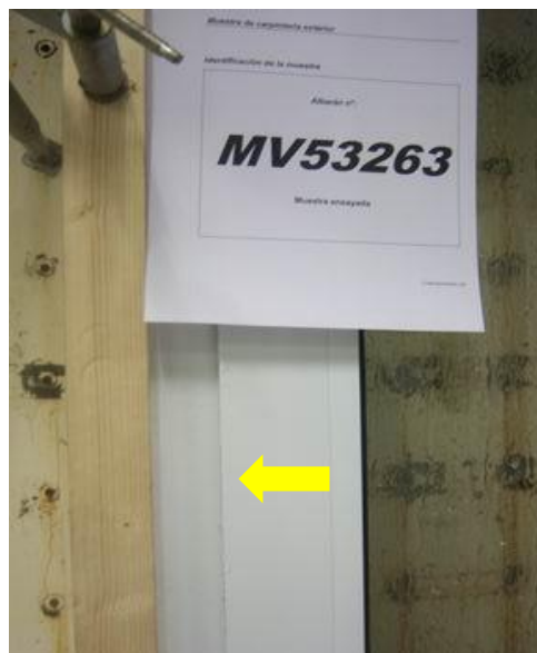
Zona de infiltrações de água
