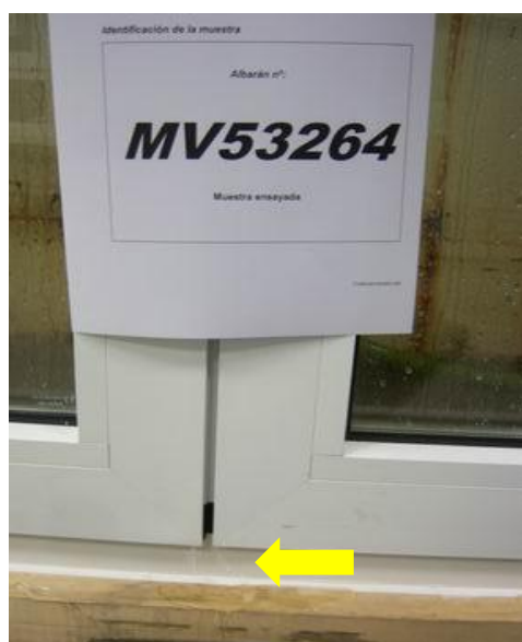
Zona de infiltrações de água
