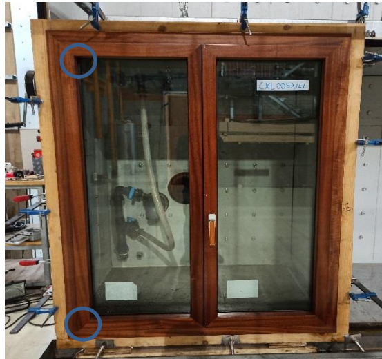
Localização dos pontos onde se identificaram as fugas de ar mais significativas
