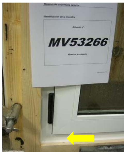
Zona de infiltrações de água
