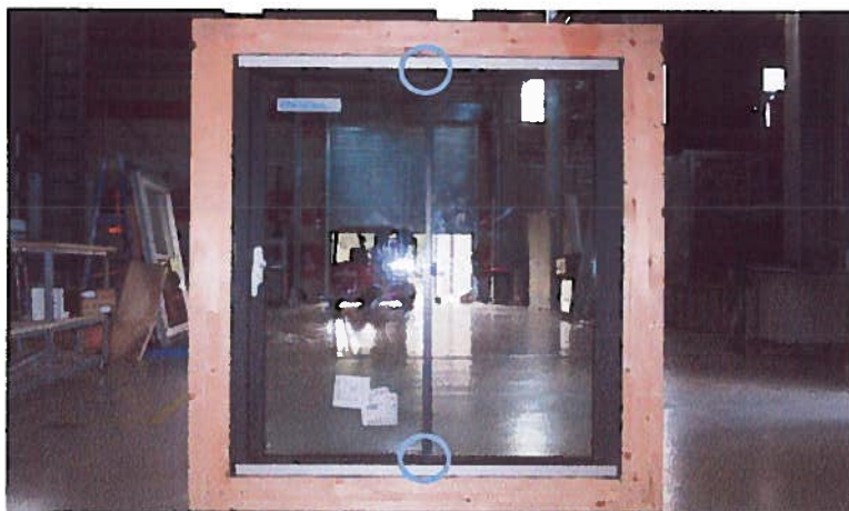
Localização dos pontos onde se identificaram as fugas de ar mais significativas
