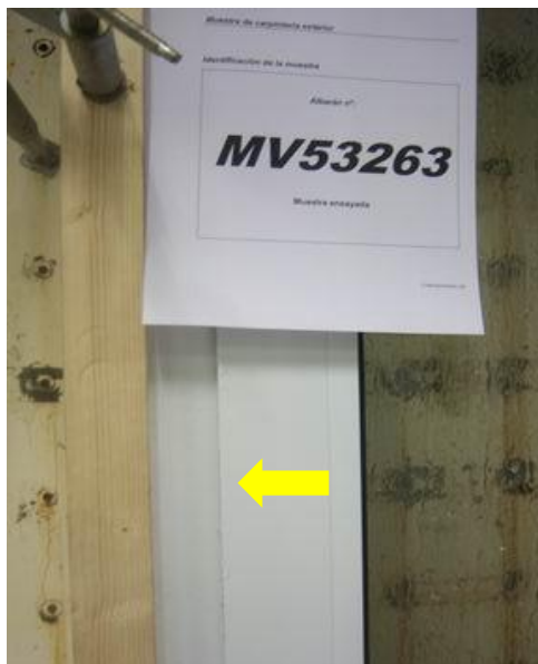
Zona filtración de agua
