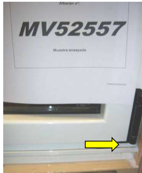
Zona de filtración de agua
