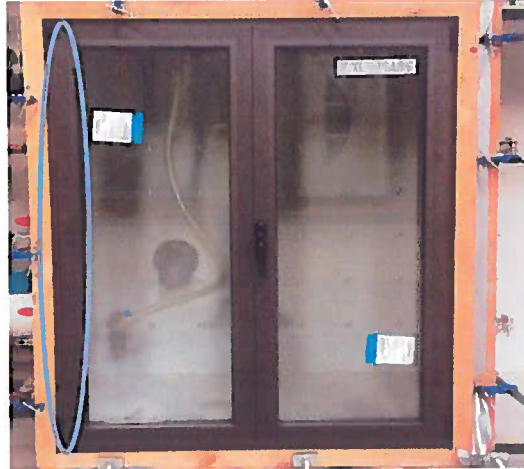
Localização dos pontos onde se identificaram as fugas de ar mais significativas
