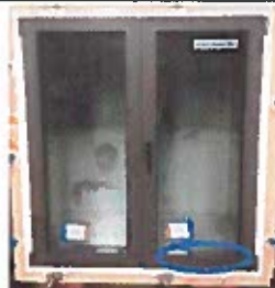
Identificação dos pontos onde se verificou a perda de estanquidade do provete
