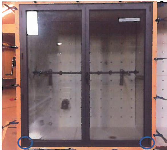
Identificação dos pontos onde se verificou a perda de estanquidade do provete
